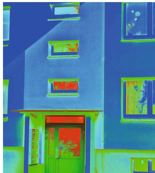
Eine vom Fachmann durchgeführte Aufzeichnung mit einer Wärmebildkamera kann vorhandene Schwachstellen genau aufzeigen.
