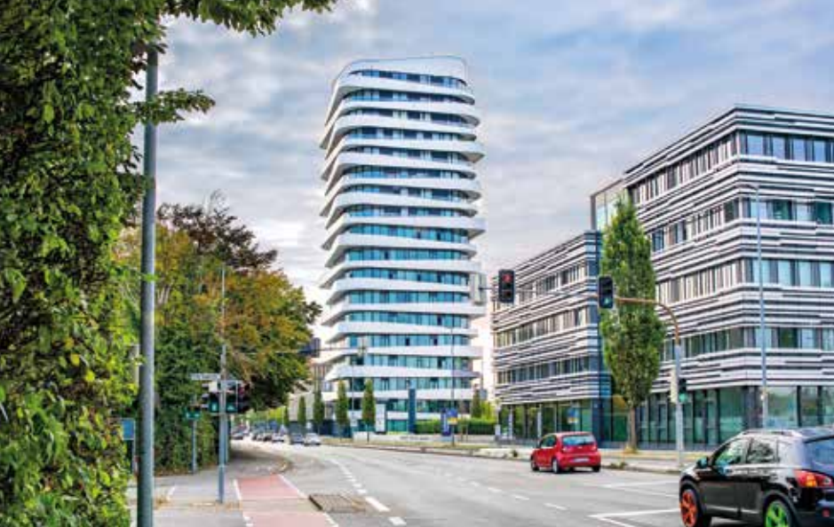
Wohn- und Geschäftshaus Sky – Bietigheim-Bissingen, Quelle: Landratsamt Ludwigsburg
