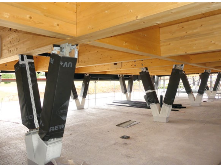
Baustelle Feuerwehrhaus Straubenhardt, Foto: Gemeinde Straubenhardt
