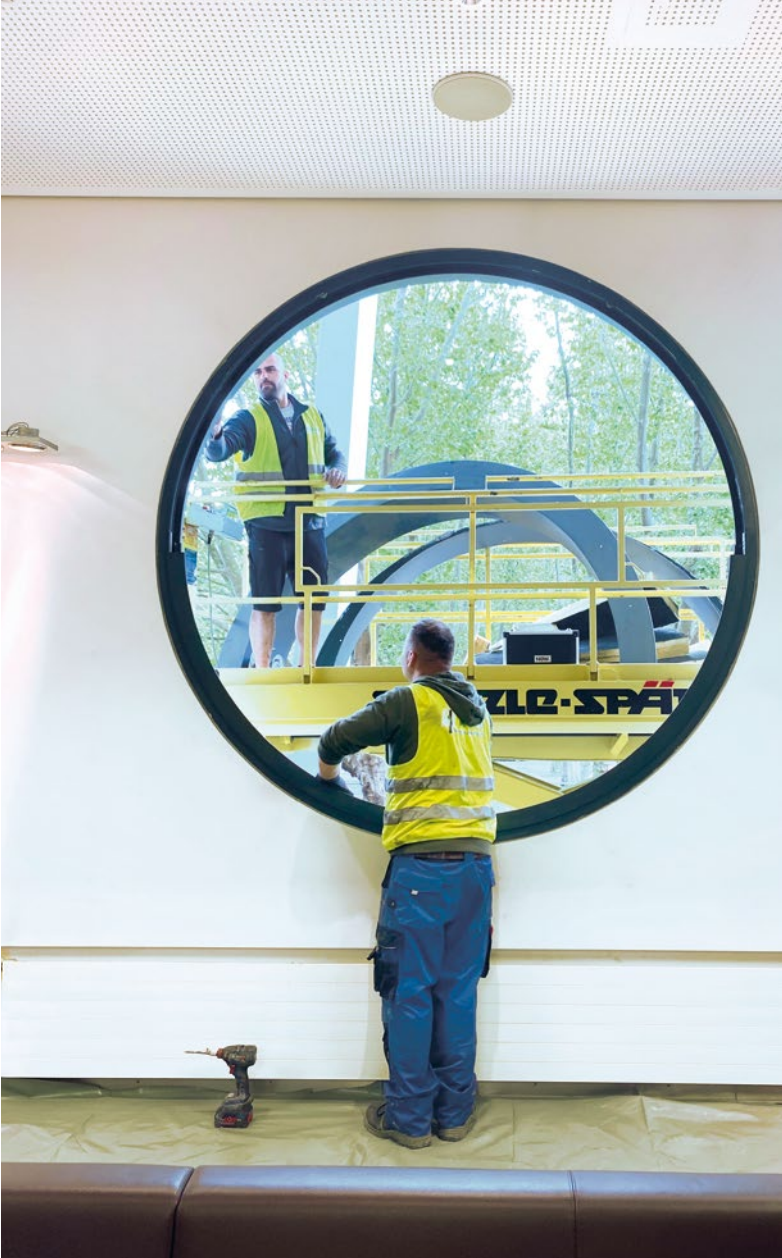
Ausbau Bullaugen im Rahmen der Modernisierung der Mercedes-Benz Arena, Foto: asp Architekten
