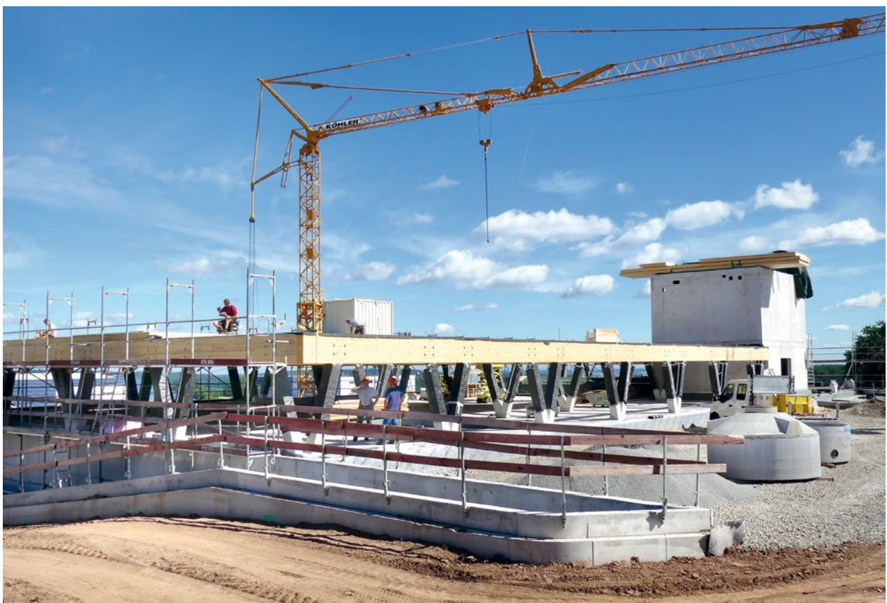
Baustellenfoto Feuerwehrhaus Straubenhardt, Foto: Gemeinde Straubenhardt
