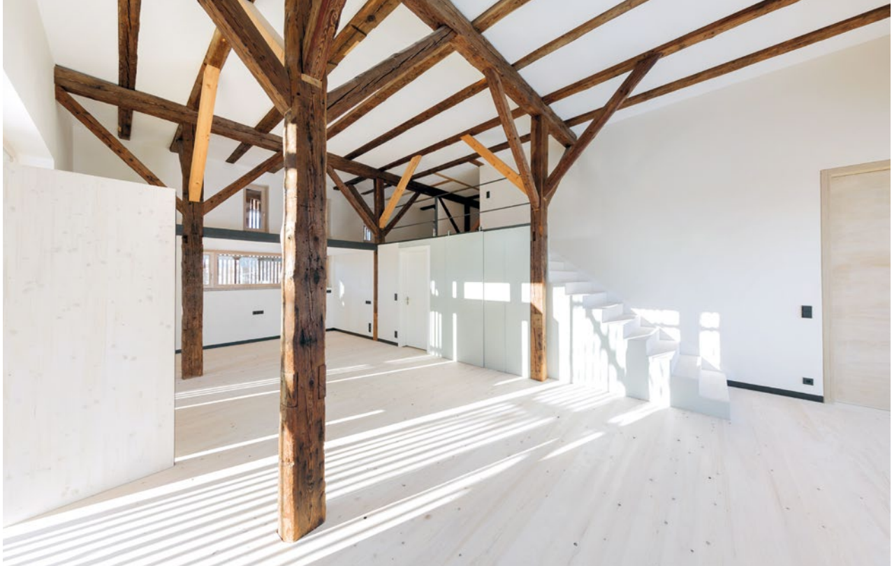
Torfremise nach dem Rück- und Wiederaufbau, Foto: ZRS Architekten Ingenieure
