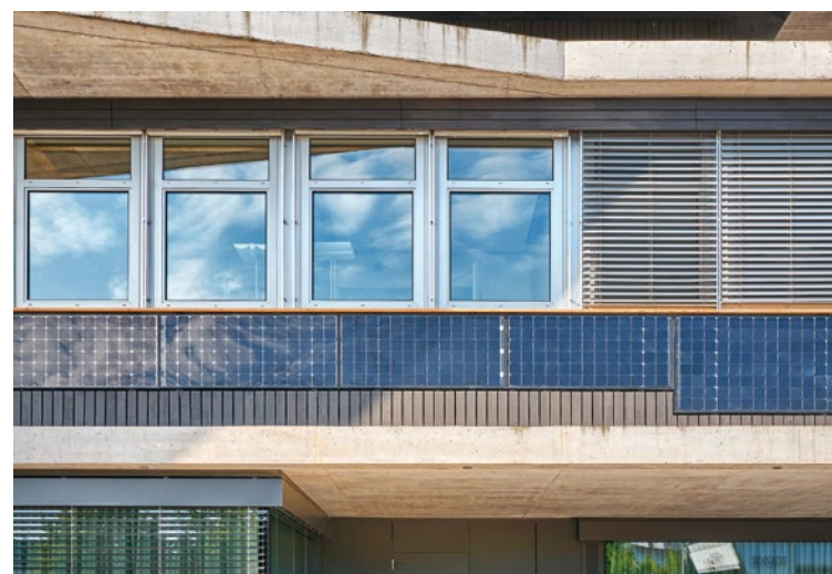
Fassadendetail Unit Sprint, Foto: Martin Zeller
