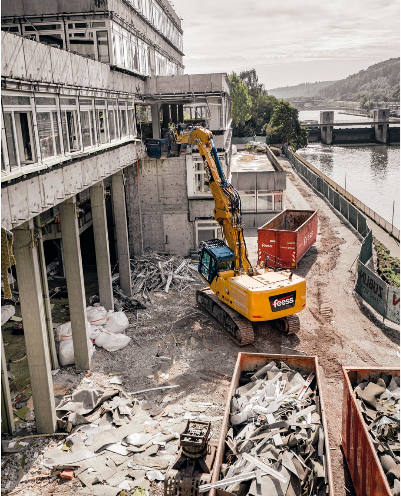
Abbruch Landratsamt Esslingen, Foto: Feess
