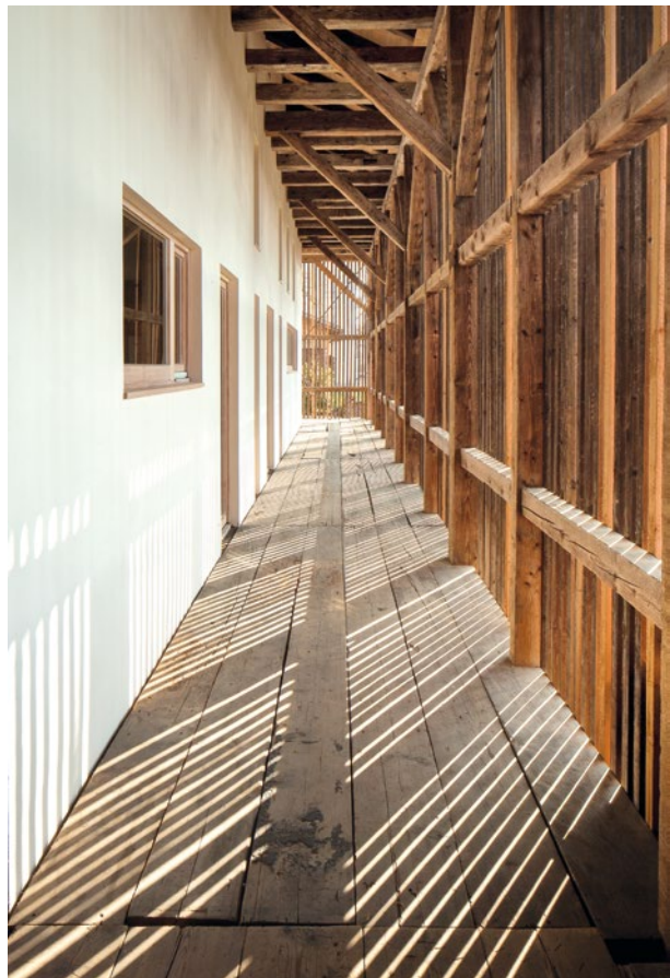
Torfremise nach dem Rück- und Wiederaufbau, Foto: Malte Fuchs
